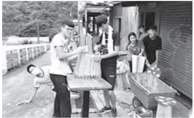
圖2 高職生投入房舍改造之實況
